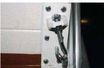
**SUPPORT DE CÂBLE** En plus de support du câble, permet le réglage de la porte.
